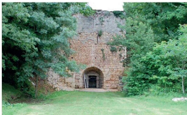
Le four à chaux des Amilières / Jazeneuil
